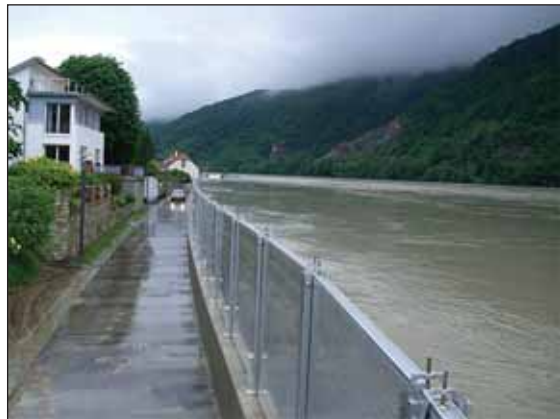
Mobilfal működés közben a nemzetközi gyakorlatban (eredeti fénykép)
